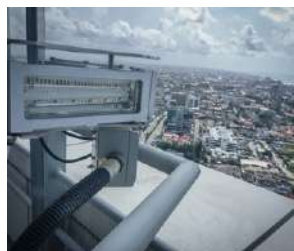
NIGERIA, Lagos, Eko Tower
