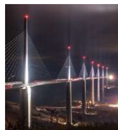
FRANCE, Pont de Millau
