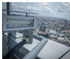
NIGERIA, Lagos, Eko Tower
