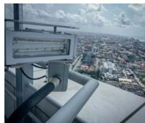
NIGERIA, Lagos, Eko Tower
