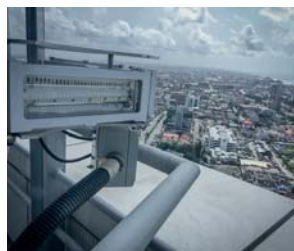
NIGERIA, Lagos, Eko Tower
