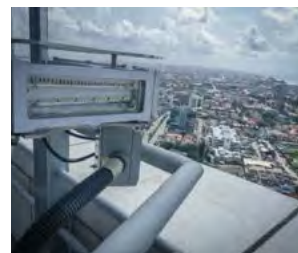
NIGERIA, Lagos, Eko Tower
