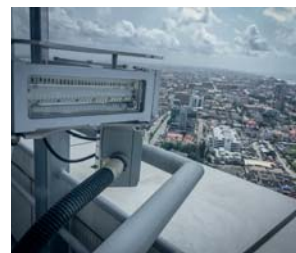
NIGERIA, Lagos, Eko Tower
