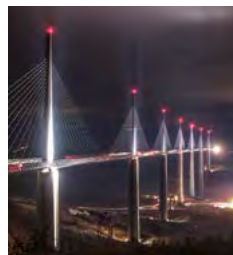
FRANCE, Pont de Millau
