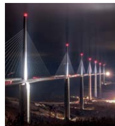
FRANCE, Pont de Millau
