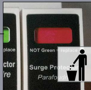
En cas de déconnexion de sécurité, le module affiche un indicateur rouge : module à remplacer
