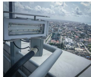
NIGERIA, Lagos, Eko Tower
